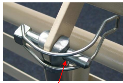
Zajištěný pojistný třmínek
